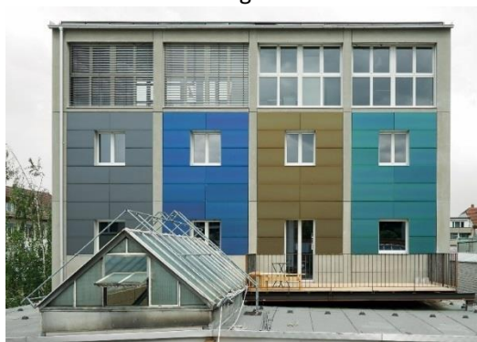
Bâtiment multi-usage «Kohlesilo», Bâle. Installation PV en façade et toiture, couvrant 37% du besoin total en énergie. Prix Solaire Suisse 2015
