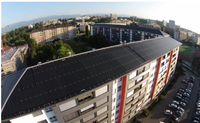
Immeuble d'habitation La Cigale, Genève, rénovation Minergie-P. 1670 m 2 de capteurs non vitrés couvrant 52% du besoin total en énergie. Prix Solaire Suisse 2014
