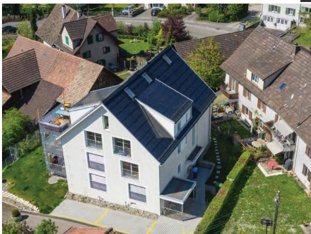
Immeuble d'habitation rénové à Oberengstringen. Installation PV de 31 kW couvrant 131% du besoin total en énergie. Prix Solaire Suisse 2015
